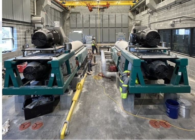
New GEA Centrifuges
